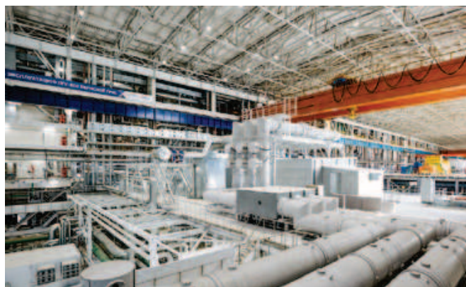
Пермская ГРЭС (ПАО «ИНТЕР РАО»). Токопроводы ТЭНЕ 10-24 кВ и ТЗК 6 кВ
