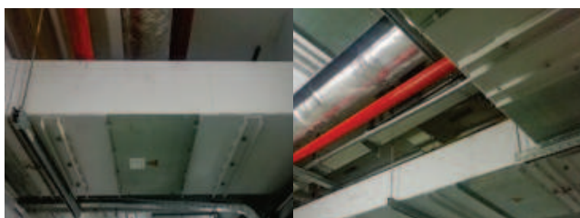
ПС 220 кВ Порт (ПАО «Кубаньэнерго»). Токопроводы ТЗП 10 кВ
