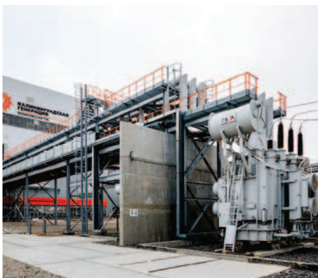
Маяковская ТЭС (ПАО «ИНТЕР РАО»). Токопроводы ТЭНЕ 10 кВ и ТЗК 6 кВ
