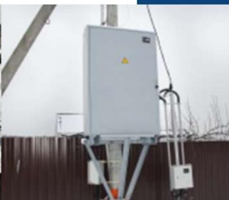
Рис. 3 Уличное исполнение стабилизатора «ПКС»
